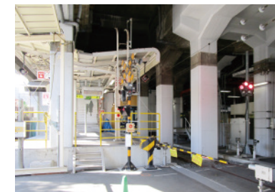
② ホーム上 作業実習コーナー ③ 踏切設備
